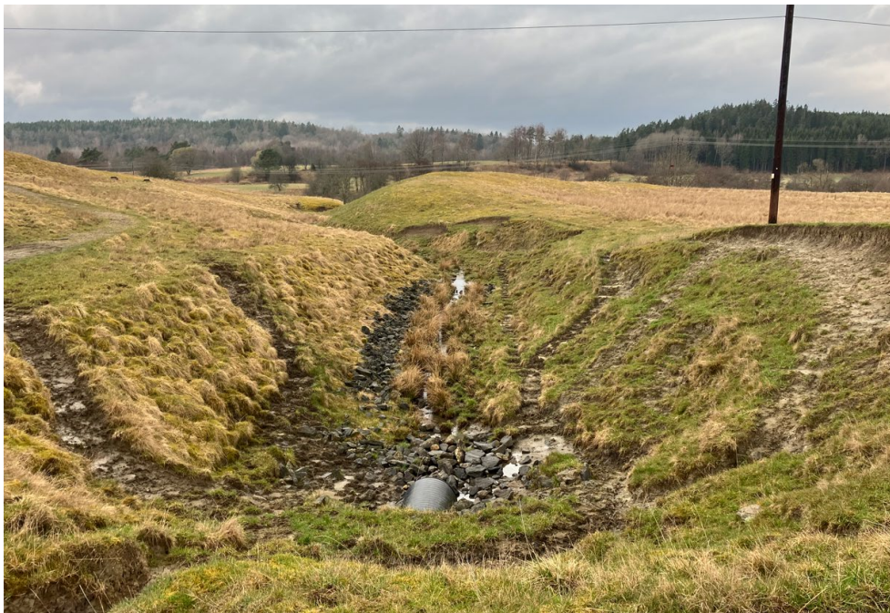
Figur 10. Dike inom naturreservatet innan Lerån. Utlopp från kulvert under Hede gårde kan ses i bildens nedre del.
