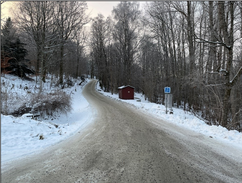
Figur 30. Svartålidan utanför fastighet Lerum Bråta 2:89, till vänster i bild.
