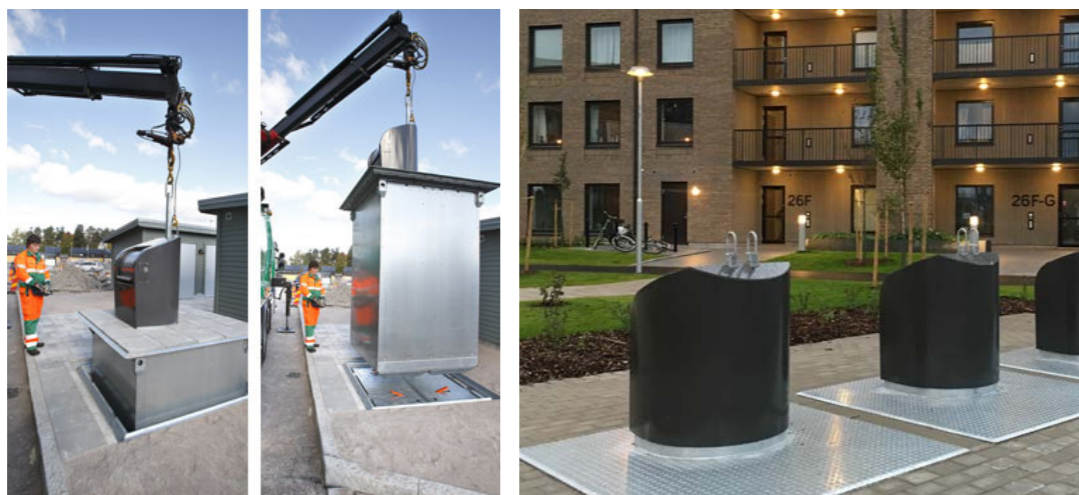
Exempel på system med underjordiska avfallsbehållare, samt tömning av desamma. Bilder från www.pwsab.se .
