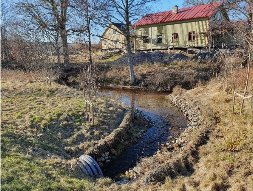
Figur 12. Exempel på V-format utlopp till bäck eller å med visst erosionsskydd
