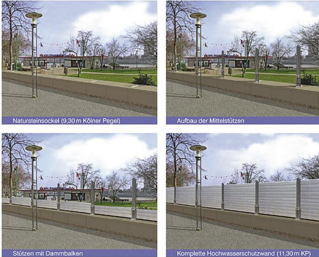
Figur 17 Exempel på ett högvattenskydd som kan monteras upp vid varningar om höga flöden.
