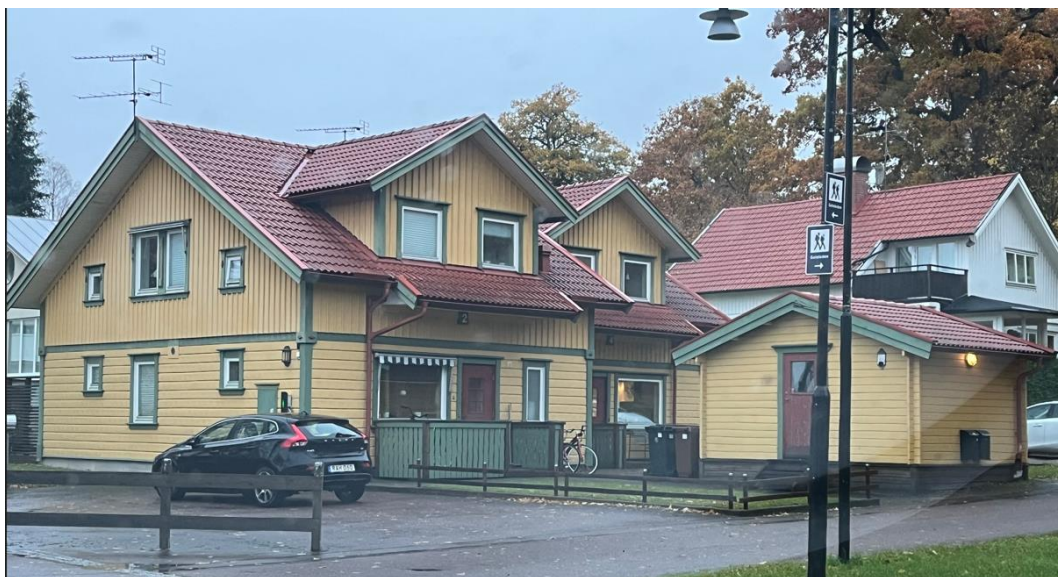
Figur 8: Bilden visar befintlig fastighet.
